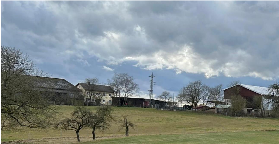
Abbildung 10 : Ansicht Dürmer Straße 70
