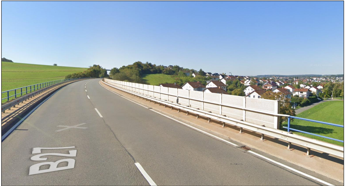
Abbildung 14: Lärmschutzbauwerk B 27 (Google Maps Street View)
