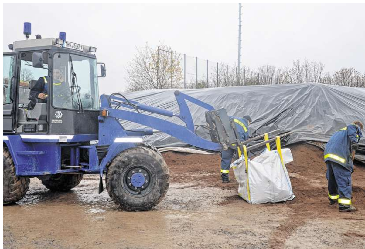
Mitarbeiter des Technischen Hilfswerks haben für die geplante Notunterkunft Stromleitungen verlegt.
