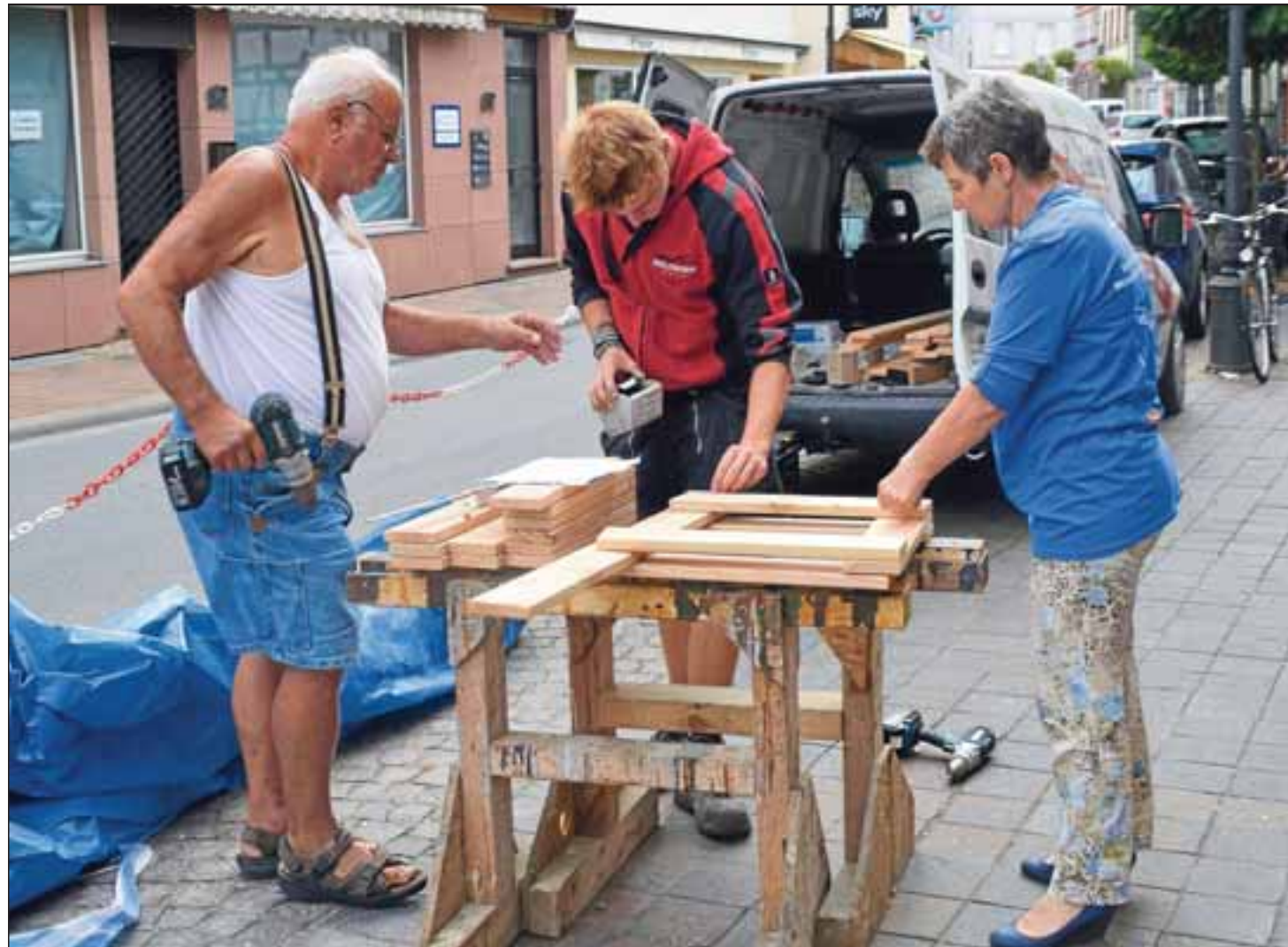
Auszubildender Sam Moe von der Firma Holzwurm zeigte den Freiwilligen, wie man mit Lärchenholz und Schrauben umgeht. Die Zimmerei stellte auch die Materialien. So entstanden zwei schöne Holzbänke.
